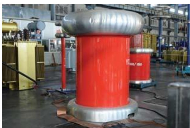
工频耐压试验装置
